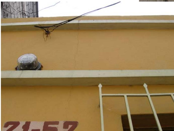
Basándose en las condiciones del terreno, las propiedades físico-mecánicas de los depósitos piroclásticos y las características ingenieriles del sistema de drenajes se considera que el hundimiento puede ser el resultado de un proceso de erosión subterránea extensiva que afectó inicialmente las paredes inferiores del pozo de visita y luego se extendió al material piroclástico circundante.
